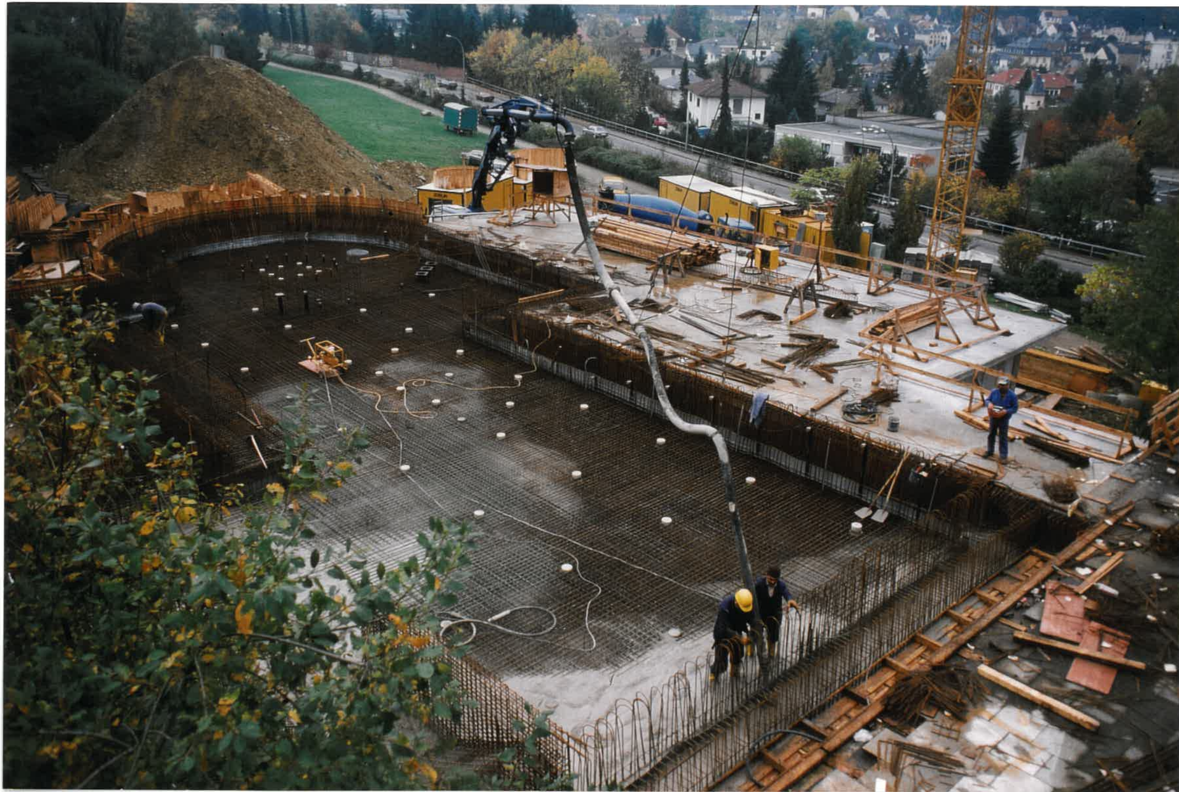
Außenbecken wird gegossen
